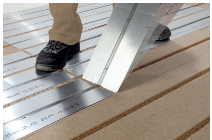
Figur 9 Värmefördelningsplattorna kan monteras/läggas stående.
