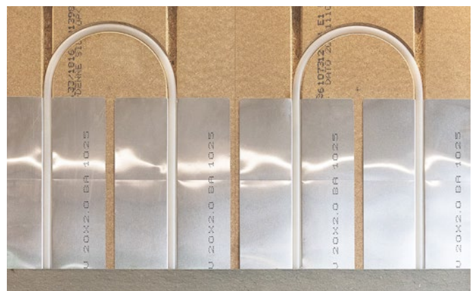
Figur 3 Värmefördelningsplattor speciellt utvecklade för 38 mm Klimagolv.
