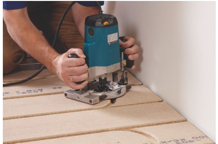
Figur 7 Fräsning av vändspår i varannan rad.
